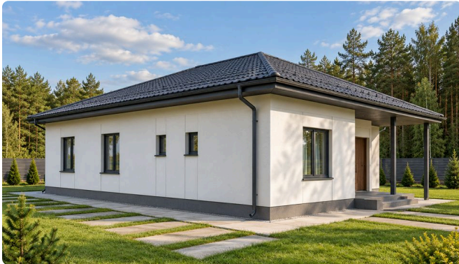
Вход и сторона спален
